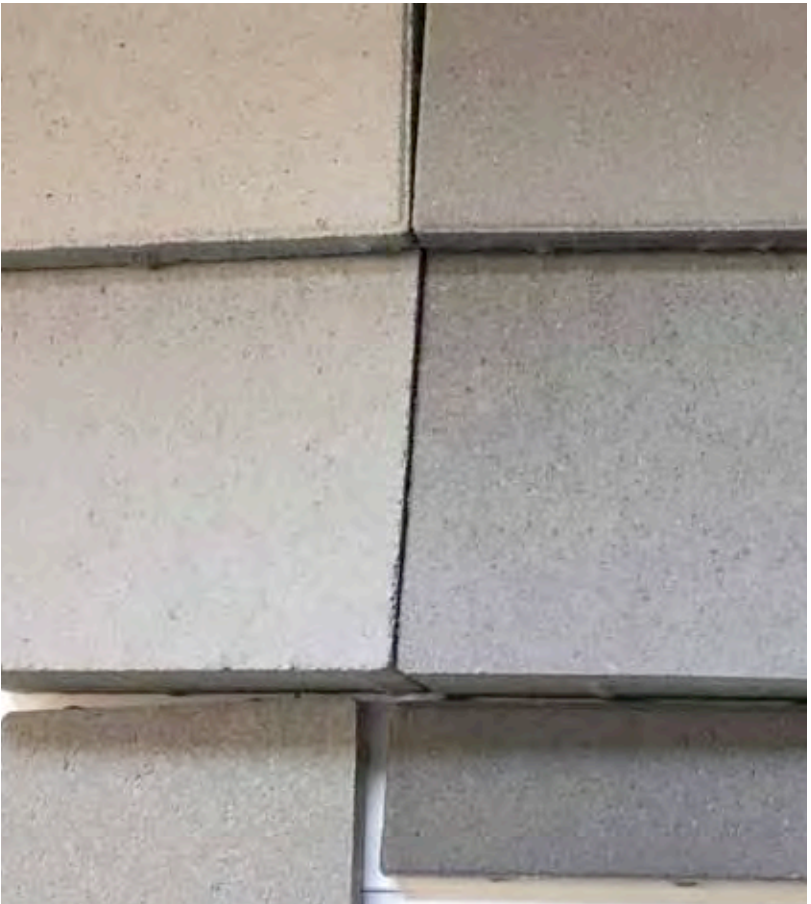
Betonpflaster 60 x 30 x 12 in Reihen mit versetzten Fugen
