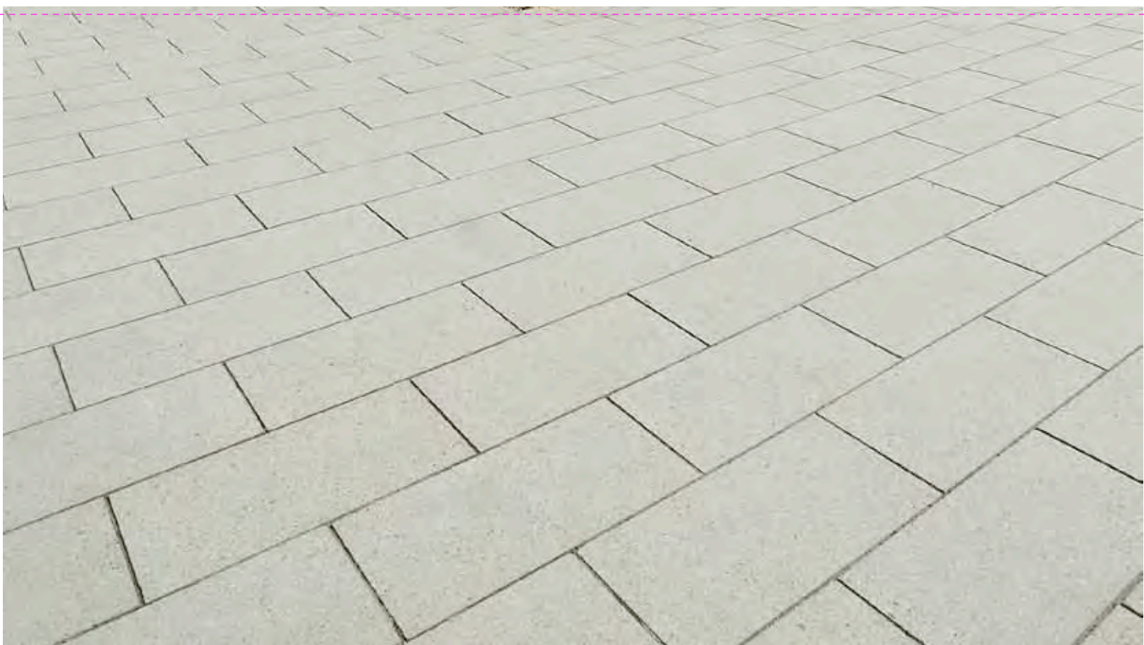
Betonpflaster 60 x 30 x 12 in Reihen mit versetzten Fugen
