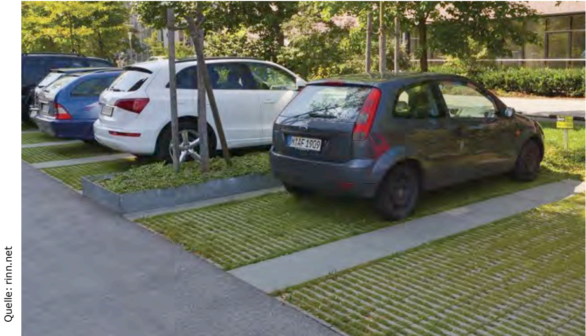
Rasenfugenpflaster mit Platten als Trennstreifen
